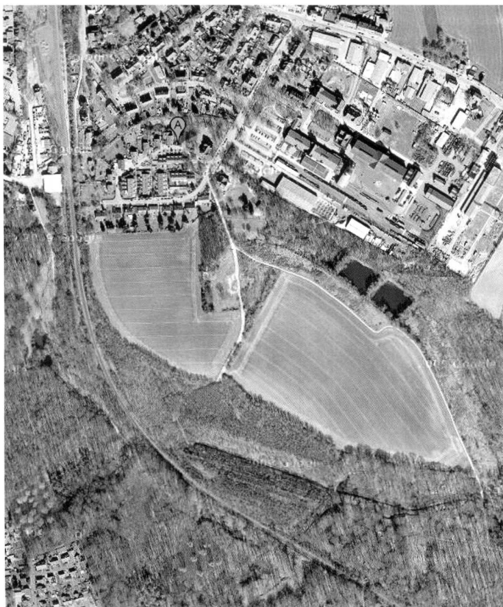
Der „Rhader Hof“ aus der Luft, Quelle: ©2009 Google
